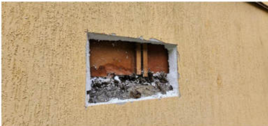
Wykonanie nowego ocieplenia na budynku oś. Wojska Polskiego 16
